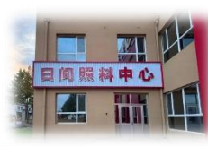
日间照料中心
